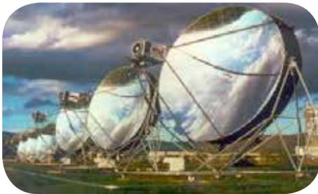
تستخدم المرايا (عواكس شمسية) أو العدسات لتركيز ضوء الشمس على مستقبلات التي توجهها الى شبكة أنابيب متصلة ملاصقة للعواكس الشمسية و تحتوي على ماء مع استمرار الحرارة ترتفع درجة حرارة الماء فيتحول الى بخار الذي يمر بدوره على توربينات متصلة بمولدات كهربائية
