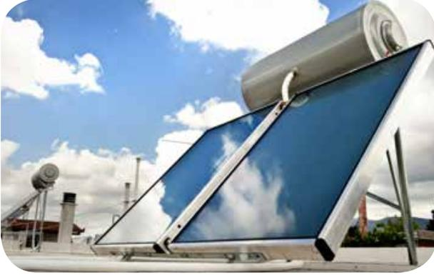
يتم استخدام سخانات المياه ذات الطاقة الشمسية لتسخين المياه في المنزل واستعمالها لغايات متعددة، وبهذه الحالة يمكن الاستغناء عن السخان الكهربائي، وبذلك يقل استخدام الكهرباء بشكل كبير، مما يساعد على التوفير والتقليل من قيمة الفاتورة. يمتاز هذا النوع من السخانات
